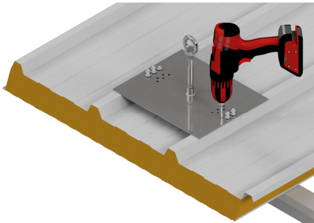
4. Platzieren Sie die Anschlagereinrichtung wieder auf den Sandwichpaneelen. Bohren Sie mit den **8 Bohrschrauben** durch die Dichtung und durch das Deckblech der Sandwichpaneel durch die jeweils 4 passenden Löcher auf jeder Seite der Anschlagereinrichtung.
